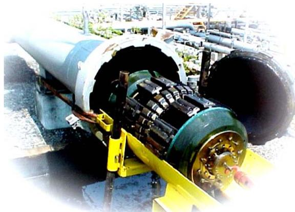
Figura 6 – *Pig* magnético sendo retirado no duto.
