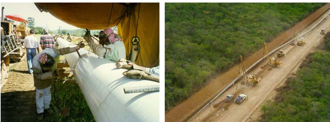
**Figura 9 – Soldagem e abaixamento do duto na construção.**
