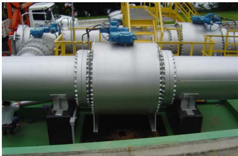
Figura 13 – Exemplo de válvula de controle tipo esfera (PCV).
